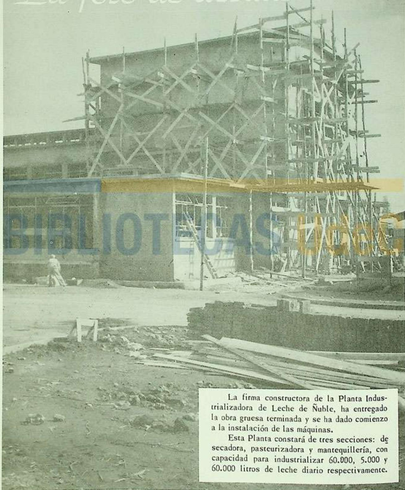
La firma constructora de la Planta Industrializadora de Leche de Ñuble, ha entregado la obra gruesa terminada y se ha dado comienzo a la instalación de las máquinas.
